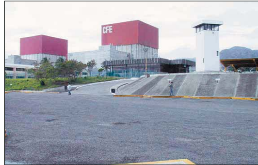
Instalaciones de la planta nuclear de Laguna Verde.
