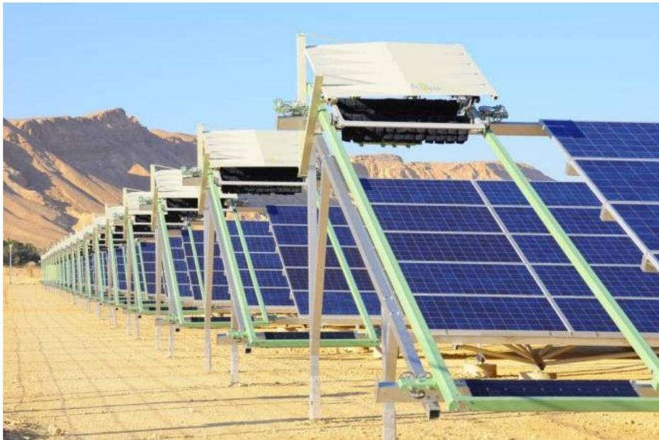
Ésta es la primera central solar del mundo con un sistema totalmente autónomo de limpieza robótica de paneles. (Foto: Ecoppia)
