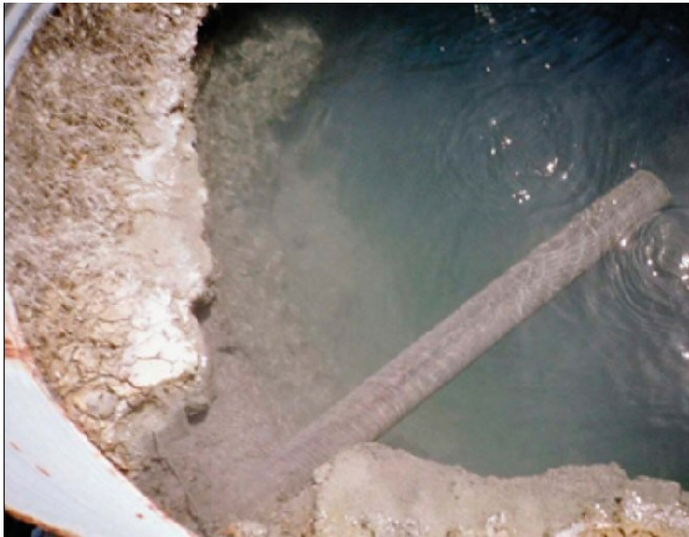
Un pozo geotérmico. (Foto: Joel Graham, University of Maryland)
